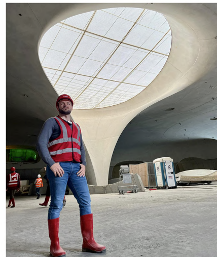
Die neue Bahnsteighalle mit den charakteristischen Kelchstützen. ▲
